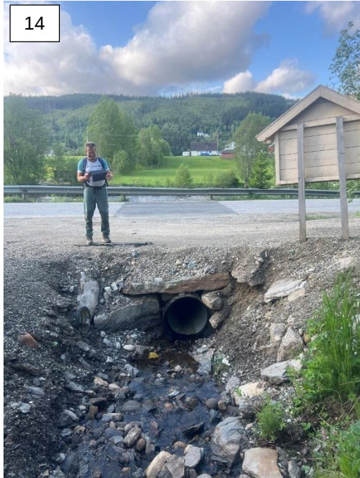
Innløp stikkrenne 600mm under fylkesveg
