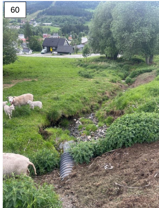
Utløp stikkrenne 400mm
