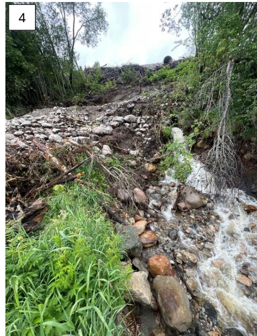
Utløp stikkrenne 400x1600mm og flomløp 1400mm under jernbanen. Bane NOR planlegger erosjonstiltak i utløp
