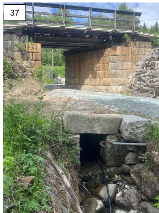
Utløp stenkanal 600mm x 500mm under vegkulvert
