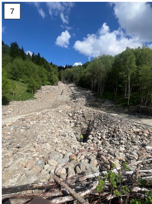
Ekstrem massetransport etter flomhendelser 2023. Bildet tatt før Bane NOR etablerte flomløp
