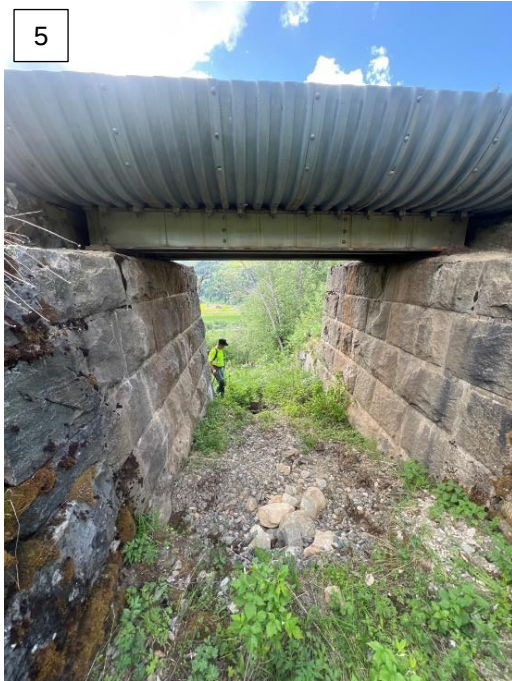
Jernbaneundergang. Aktuell som flomløp/overløp for Gryta
