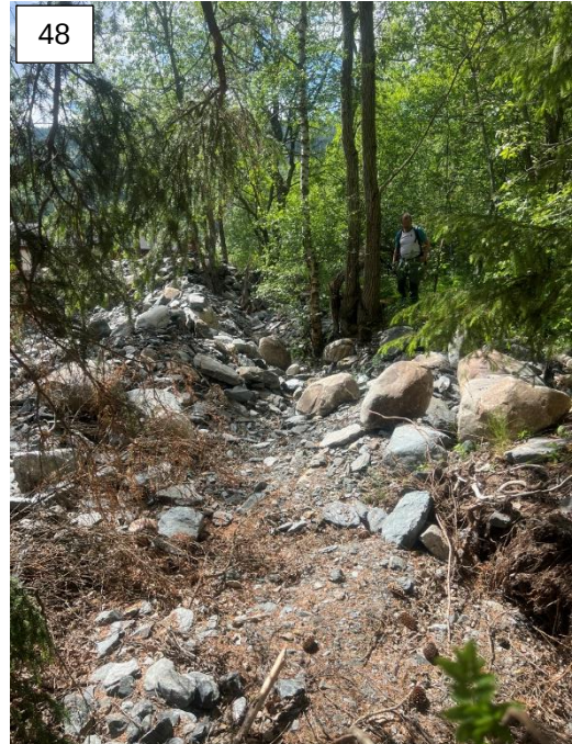
Grøft/voll som leder mot bolig. Vann kommer til å gå mot huset ved flomhendelse
