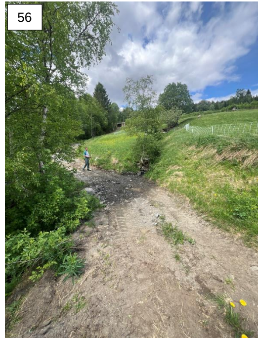
Bekk flommer over landbruksvei ved større flomhendelser. Risikerer å få vann på avveie mellom stabbur og bolighus, og ev. nedover veien
