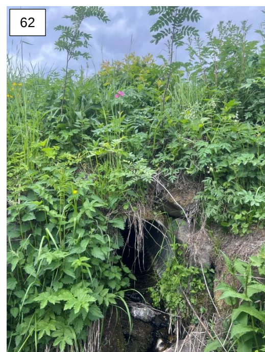
Utløp stikkrenne 500mm. Eldre stålrør, så det er skjøtet et sted mellom innløp og utløp. Sårbart
