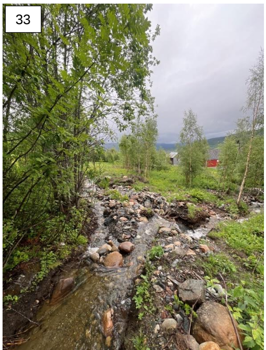
Almåsbekken forsøkt avskjært mot øst (venstre i bildet). Brudd i voll, så det renner vann i begge retninger
