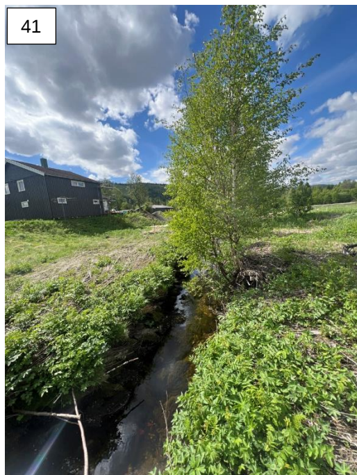
Det har flommet over på begge sider av Olderåa i forkant av flomvoll.
