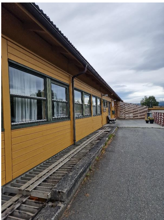
Figur 5: Vinduer fra byggeår.
