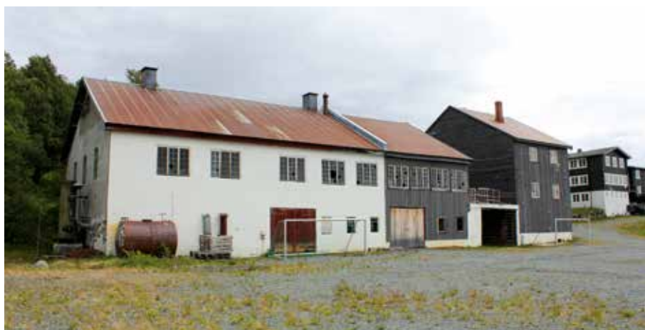
Raudbrakka og verkstedbrakka i Bjørgåsen, Holtålen
