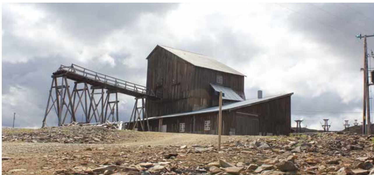
Taubanestasjonen på Olavsgruva
