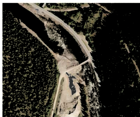
Situasjon 2011 – etter flommen
